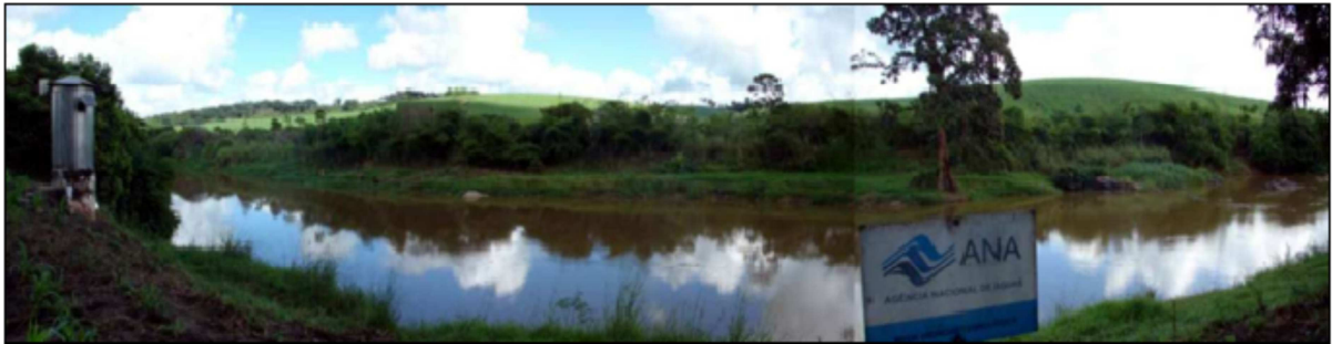
Figura 16 – Estação Hidrológica da Fazenda Boa Fortuna no Rio Mundaú, município de Rio Largo
