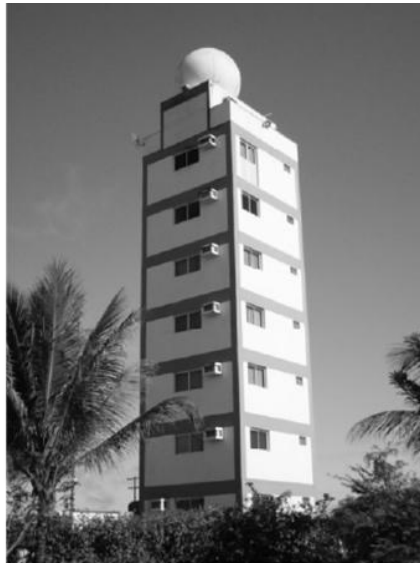
Figura 6 – Torre do radar em Maceió – Alagoas – Brasil (9°33’3’S, 35°46’14”W), 25m de altura, 104m de altitude.
