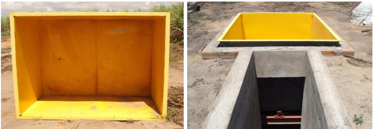
Figura 8. Caixa interna e instalação do lisímetro.
