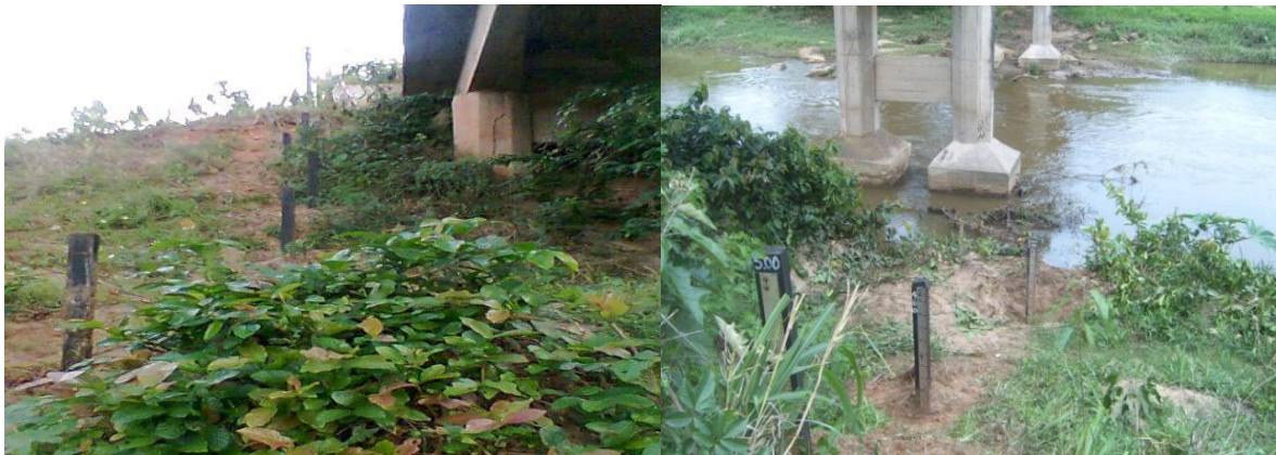
Figura 2- Aspecto visual do Ponto 1. Conjunto de Régua Limnimétrica;
