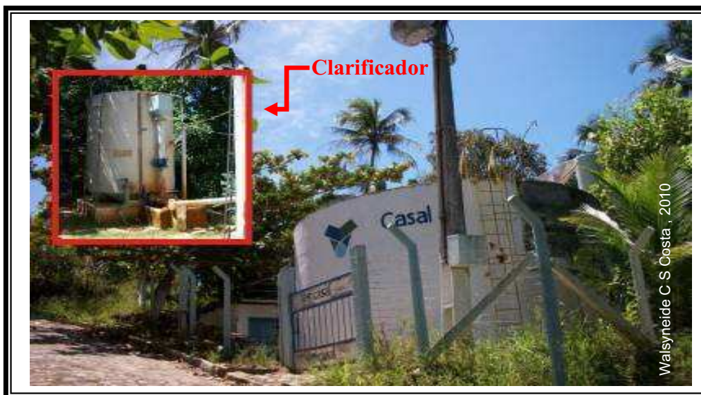
Figura 17: Estação de tratamento: Tipo compacta.
