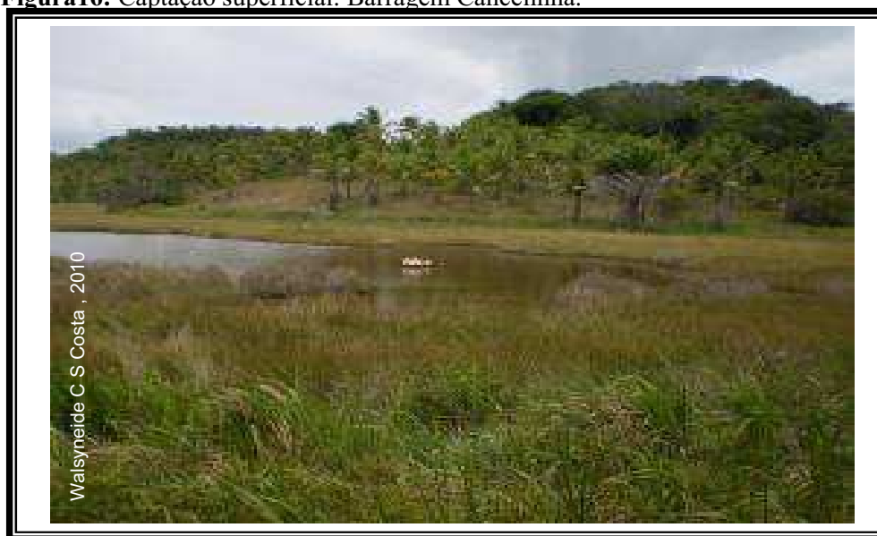
Figura 16: Captação superficial: Barragem Cancelinha.
