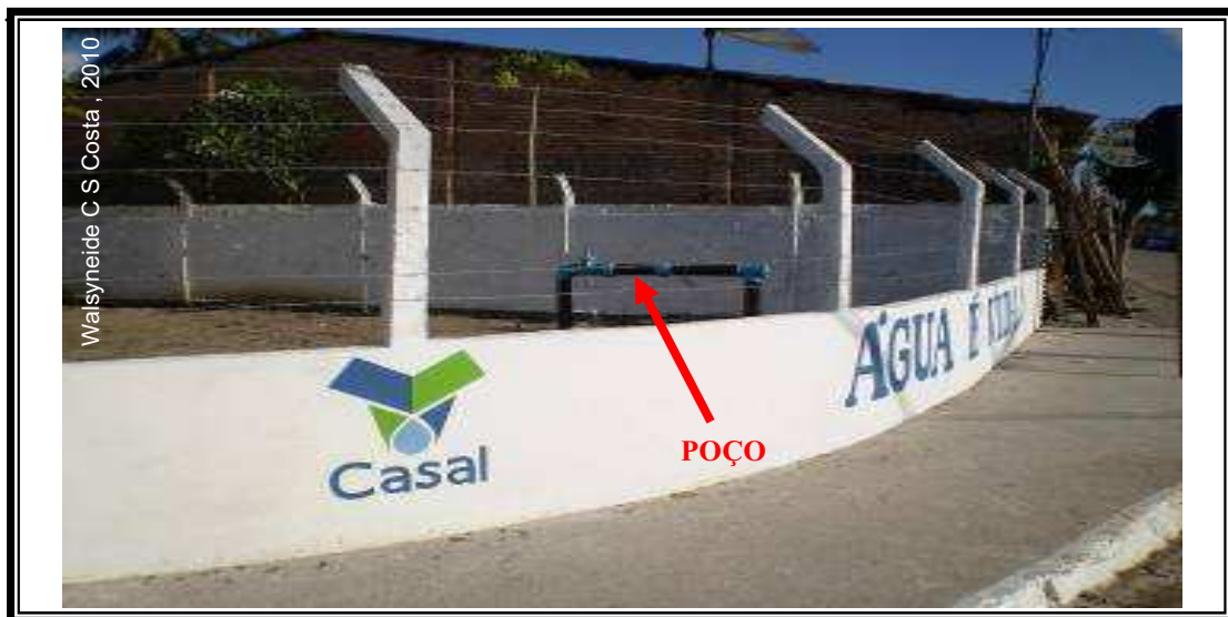
Figura11: Sistema de abastecimento: Poço profundo.
