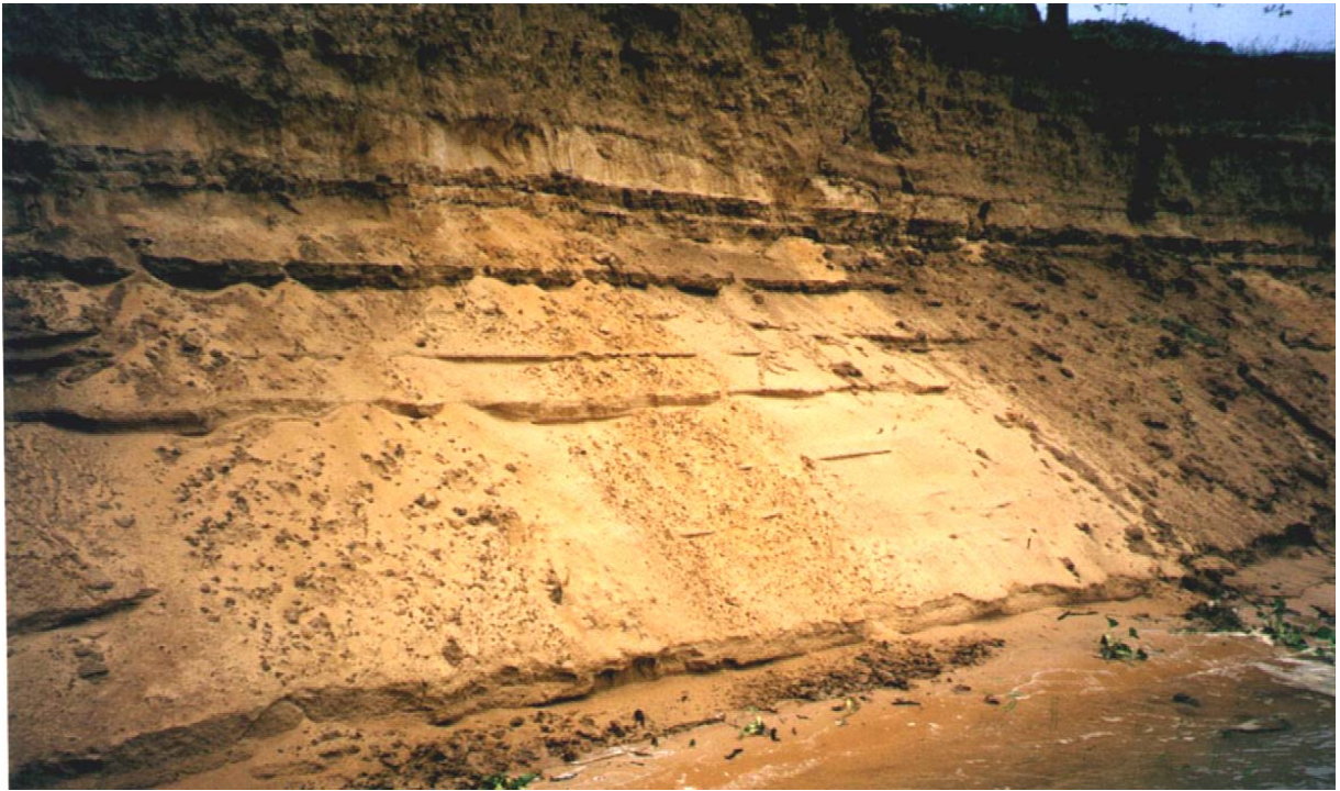
Figura 55 – Barranco na margem esquerda a montante de Traipú, sujeito à erosão.
